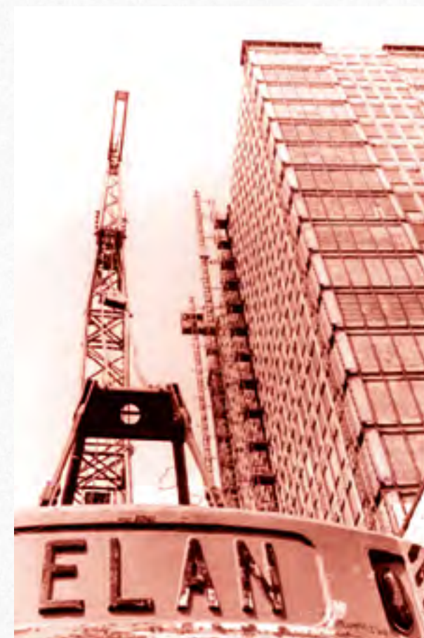
Stavba budovy A1
