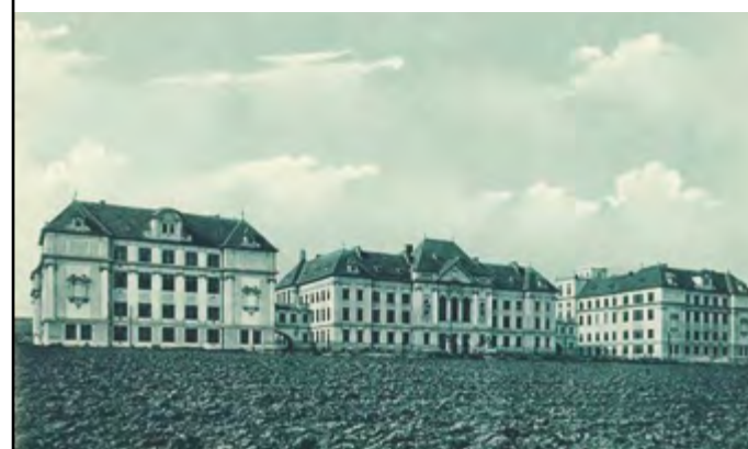
Stavba nové budovy v ulici Veveří The construction of a new building in Veveří Street
