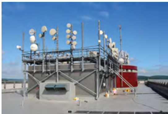
Střecha „Á-jedničky“ Roof of "A-ones"
