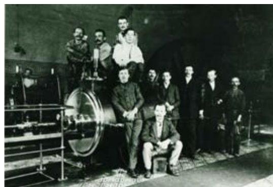
Cvičení obsluhy kotlů Ústavu teoretické nauky o strojích v roce 1910 Practice of boiler operation of the Institute of Theoretical Machine Science in 1910
