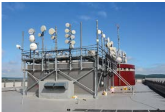
Střecha „Á-jedničky“ Roof of "A-ones"
