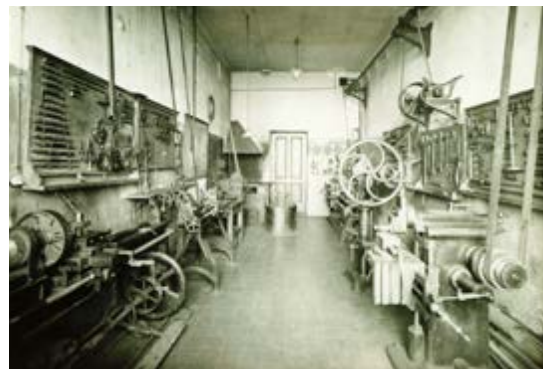
Strojní tepelná laboratoř Mechanical Thermal Laboratory
