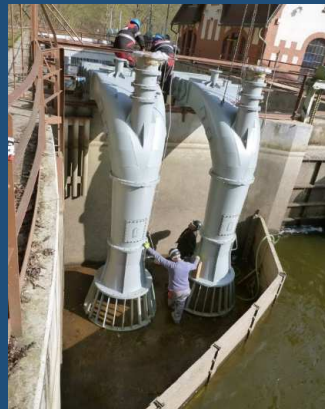
nový typ vodní turbíny – vírová turbína
